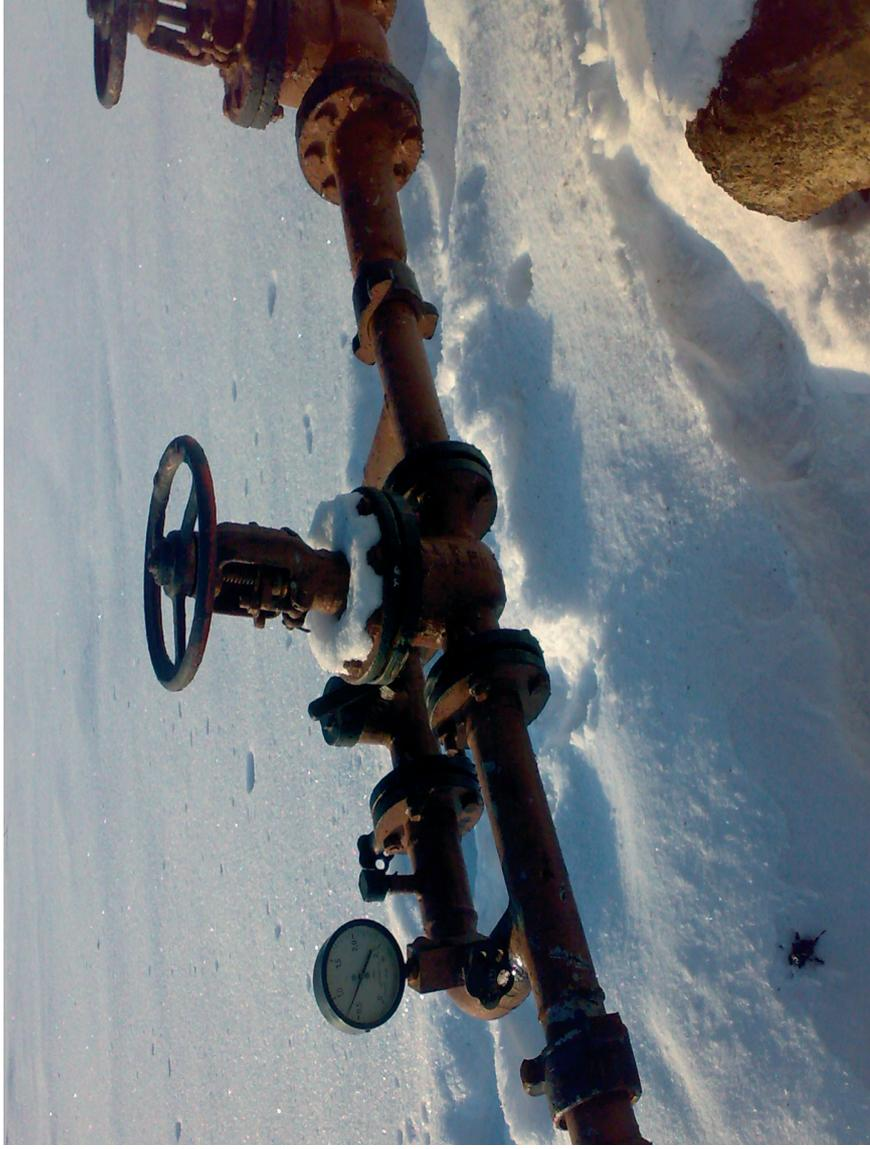
Рис. 8.11. Скв. 371 Гремихинского месторождения. Узел технологического контроля установлен перед секущей задвижкой. Не удален прежний пробоотборник с манифольда для сравнения с УТК.
