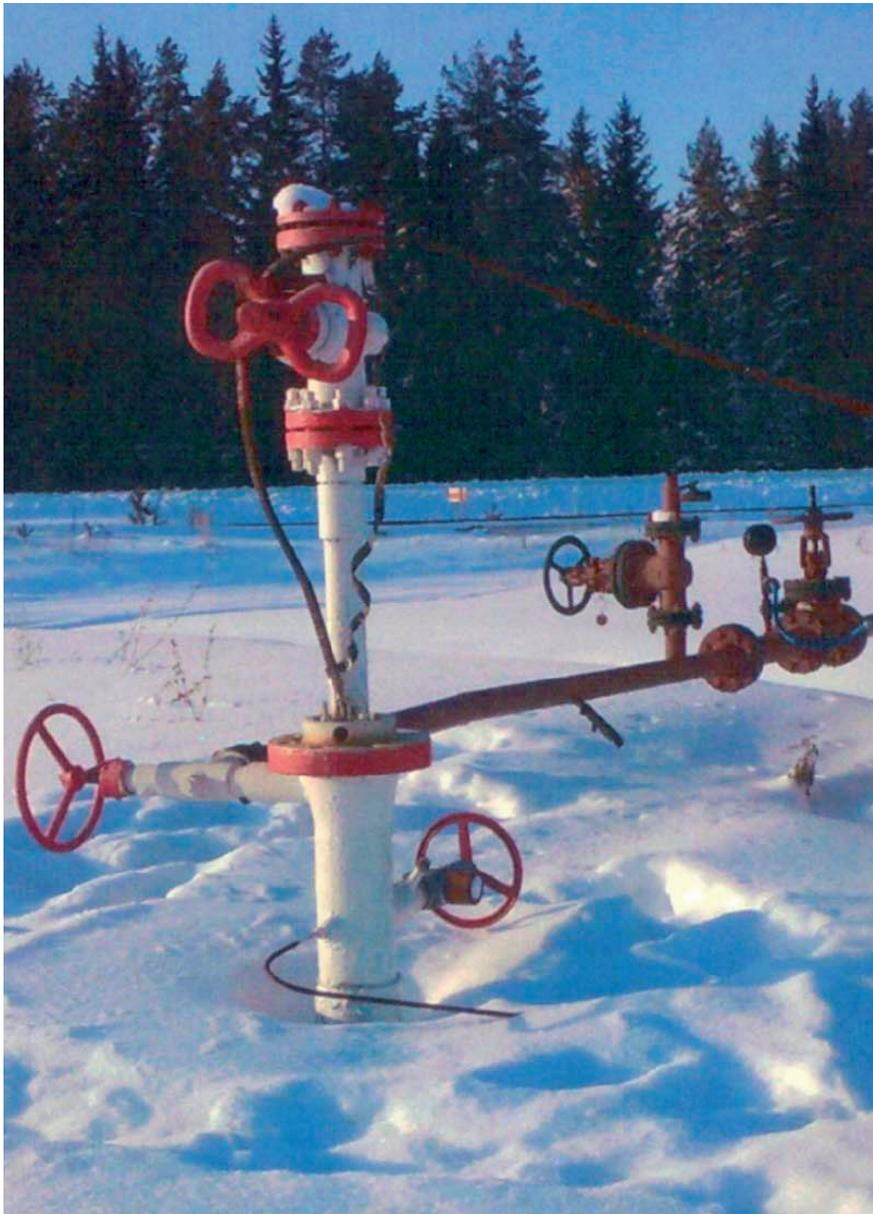
Рис. 8.2. Пробоотборник смонтирован снизу, нет термокармана и обратного клапана.
