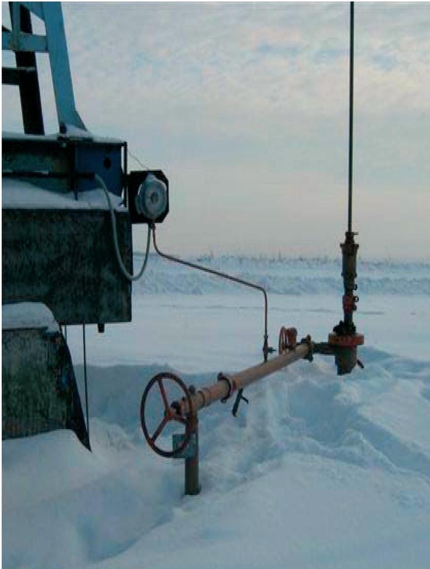
Рис. 8.4. Кырыкмасское месторождение. Электроконтактный манометр установлен на отдельном щите, меньше вероятности повреждения кабеля, удобен для опрессовки скважины. Секущий запорный орган вентиль - не клинит при опрессовке.
