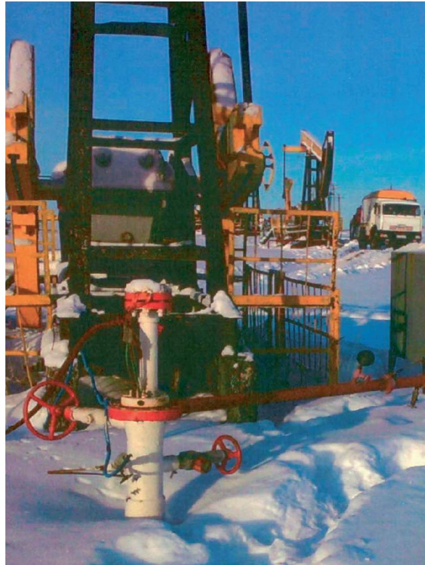
Рис. 8.1. Скв. 685 Гремихинского месторождения. Нет буферной задвижки, манометр установлен неправильно (на разбираемой части манифольда), пробоотборник смонтирован снизу, нет обратного клапана и термокармана.
