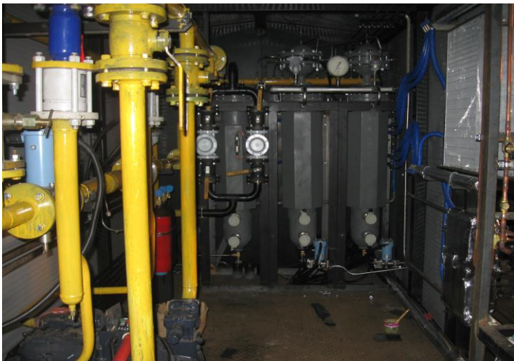
Рисунок 2. Внутренний вид рабочего отделения установки
