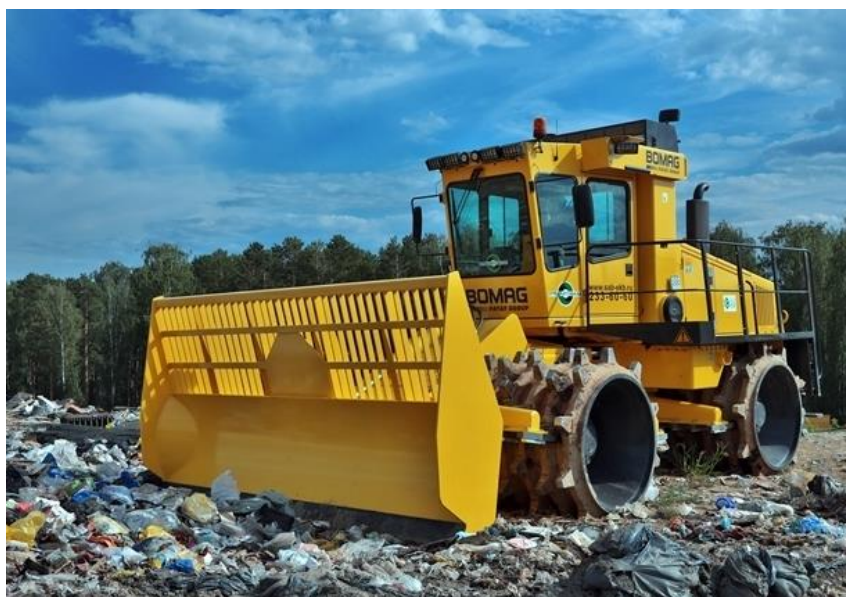
Рисунок 2 – Разравнивание и уплотнение отходов на полигоне
