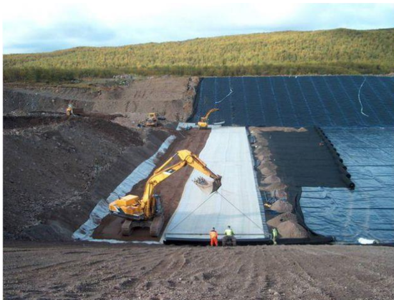
Рисунок 1 – Строительство защитного экрана дна полигона
