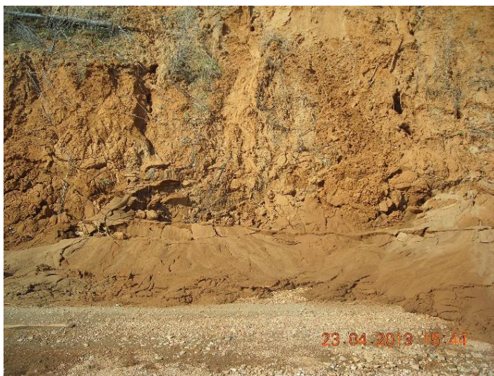
Рис. 14.2. Размывы суглинков по трещинам. Воткинское водохранилище.
