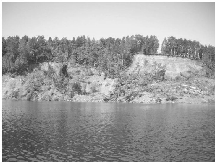
Рис. 9.6. Два крупных разновозрастных оползня на Воткинском водохранилище. Справа – оползень-обвал, образовавшийся в 2002 г., слева – оползень-спływ, произошедший в 2007 г.
