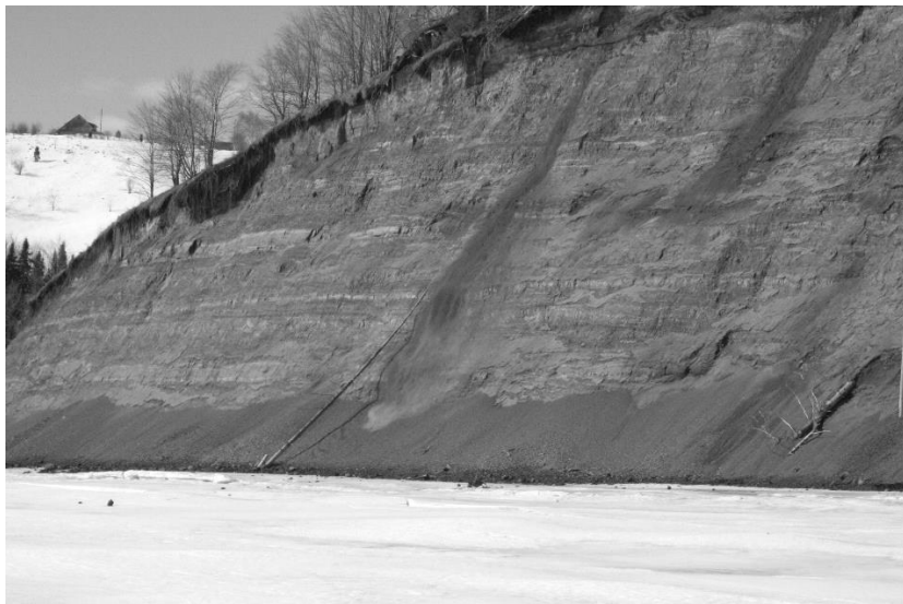
Рис. 8.1. Осыпной склон, берег Воткинского водохранилища. Осыпь шлейфа подножья.
