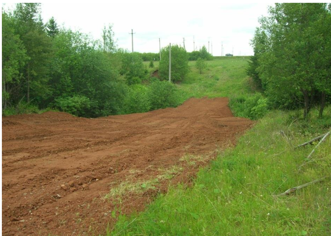
Рис. 4.5 Ликвидация активно растущего оврага путем засыпания грунтом на ключевом участке «Медведево» в 2009 г.
