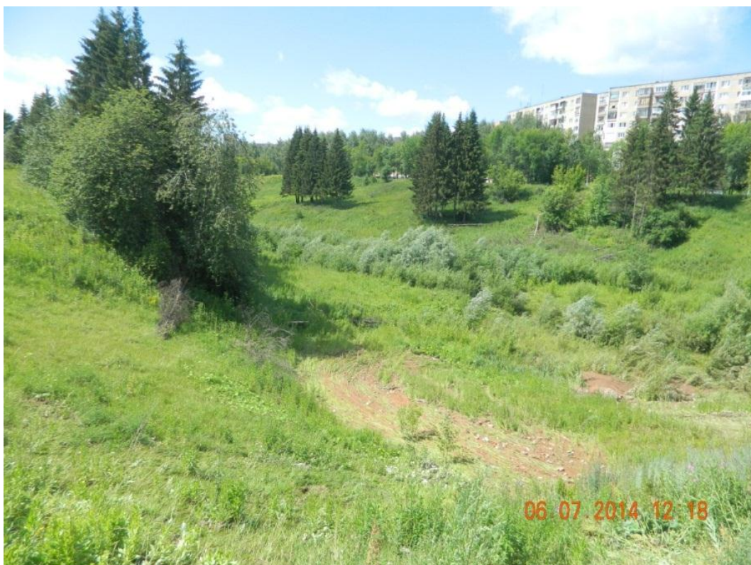
Рис. 2.9 Урбоовраг в микрорайоне «Старый Аэропорт» в г. Ижевске
