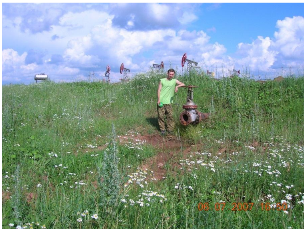
Рис. 5.12. Водосливное устройство с площадки нефтедобычи на Медведевском месторождении в Завьяловском районе УР
