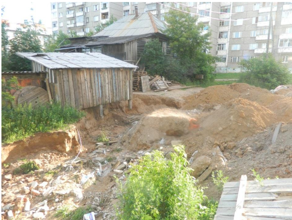
Рис. 4.25. Овраг, возникший после катастрофического ливня 19 июня 2012 г. на ул. 3-я Подлесная в Октябрьском районе г. Ижевска
