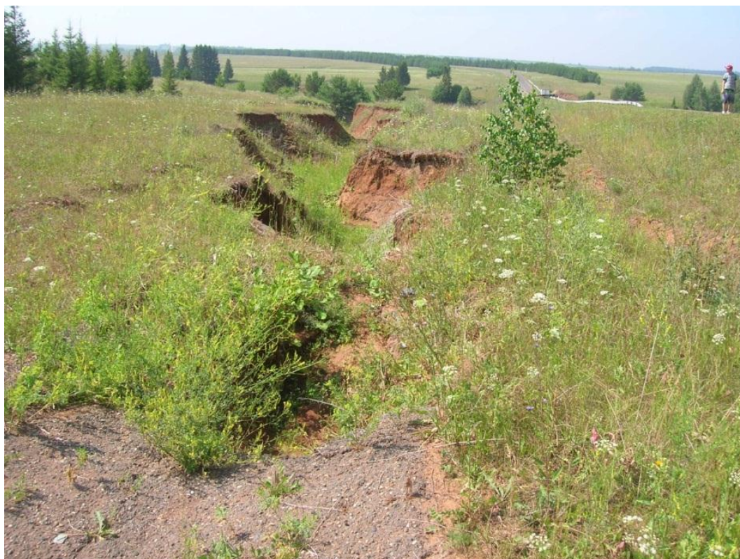
Рис.5.11. Разрушение асфальтового лотка растущим кюветным оврагом у с.Бемыж Кизнерского района УР
