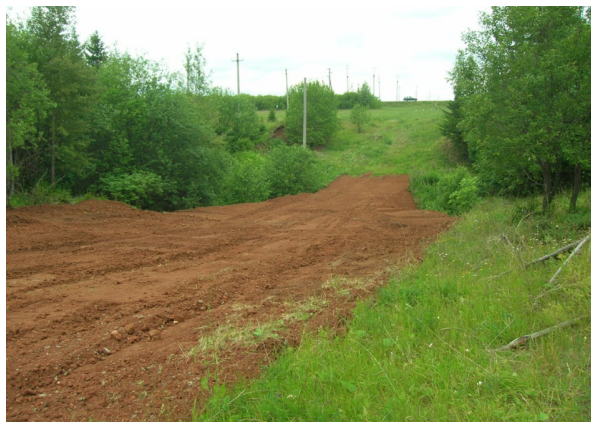
Рис. 2 Ликвидация активно растущего оврага путем засыпания грунтом на ключевом участке «Медведево» в 2009 г.
