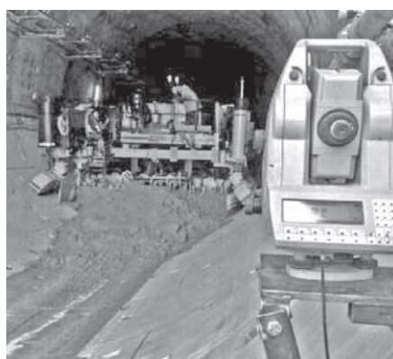
Рис. 5. Работы в тоннеле
