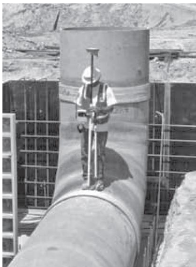
Рис. 6. Геодезические работы в зонах газонефтепроводов
