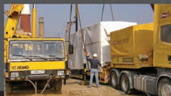
Доставка и монтаж
