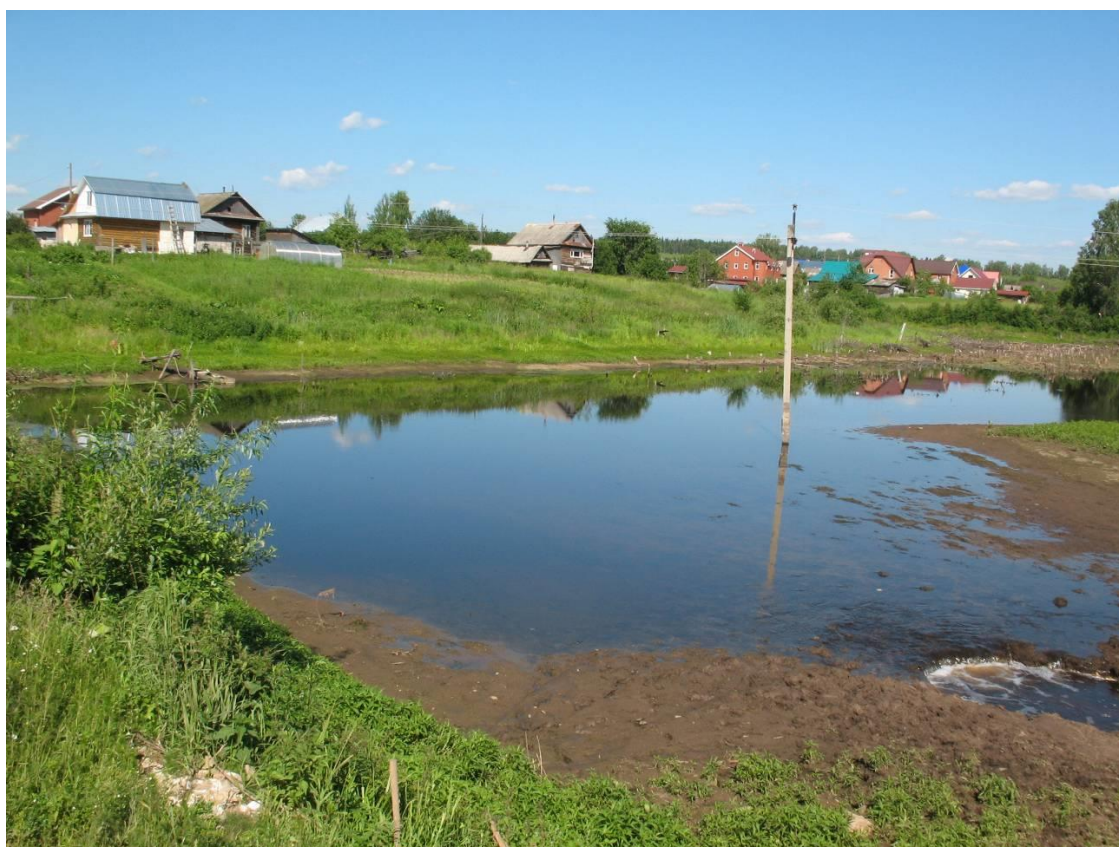
Фото. 1. Ложе пруда с опорой ЛЭП
