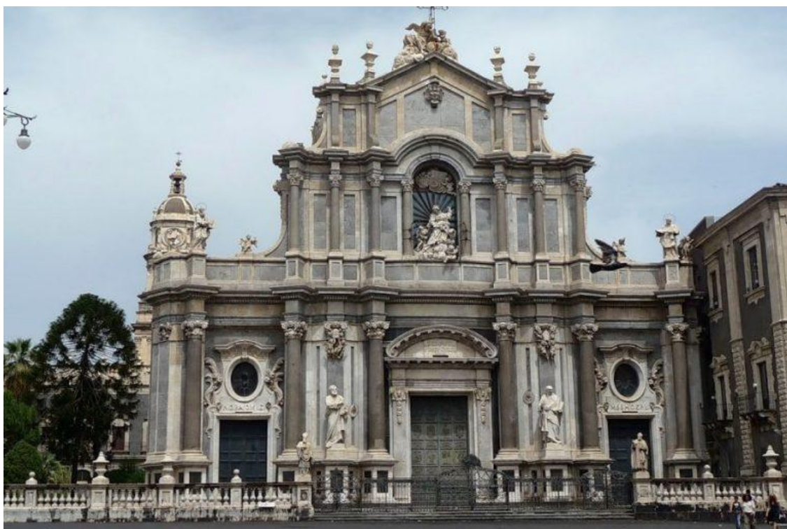
Илл. 1. Италия. Типичный фасад церкви барокко
