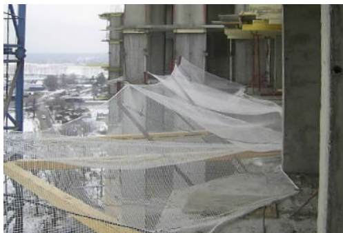
Рис. 1. Горизонтальная страховочно-улавливающая сетка
