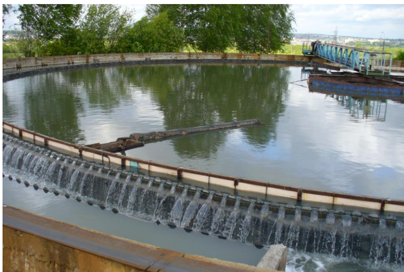
Рис. 27а Водосборный кольцевой лоток
