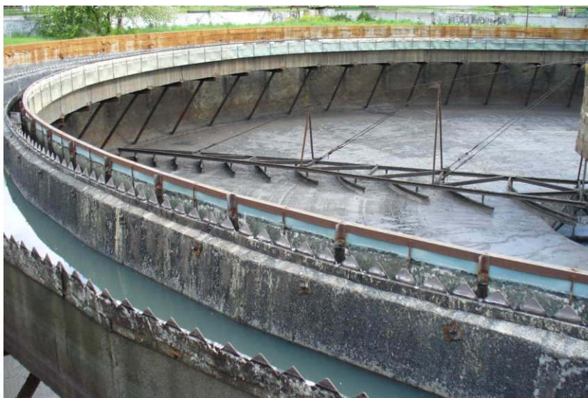
Рис. 27б Скребковый механизм для сбора осадка
