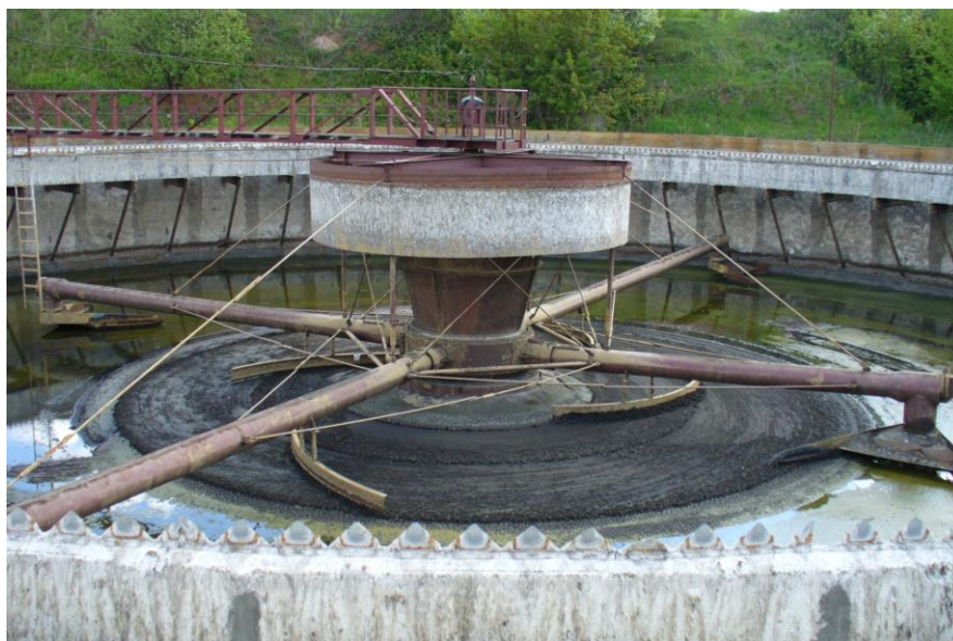
Рис. 32 Вторичный отстойник
