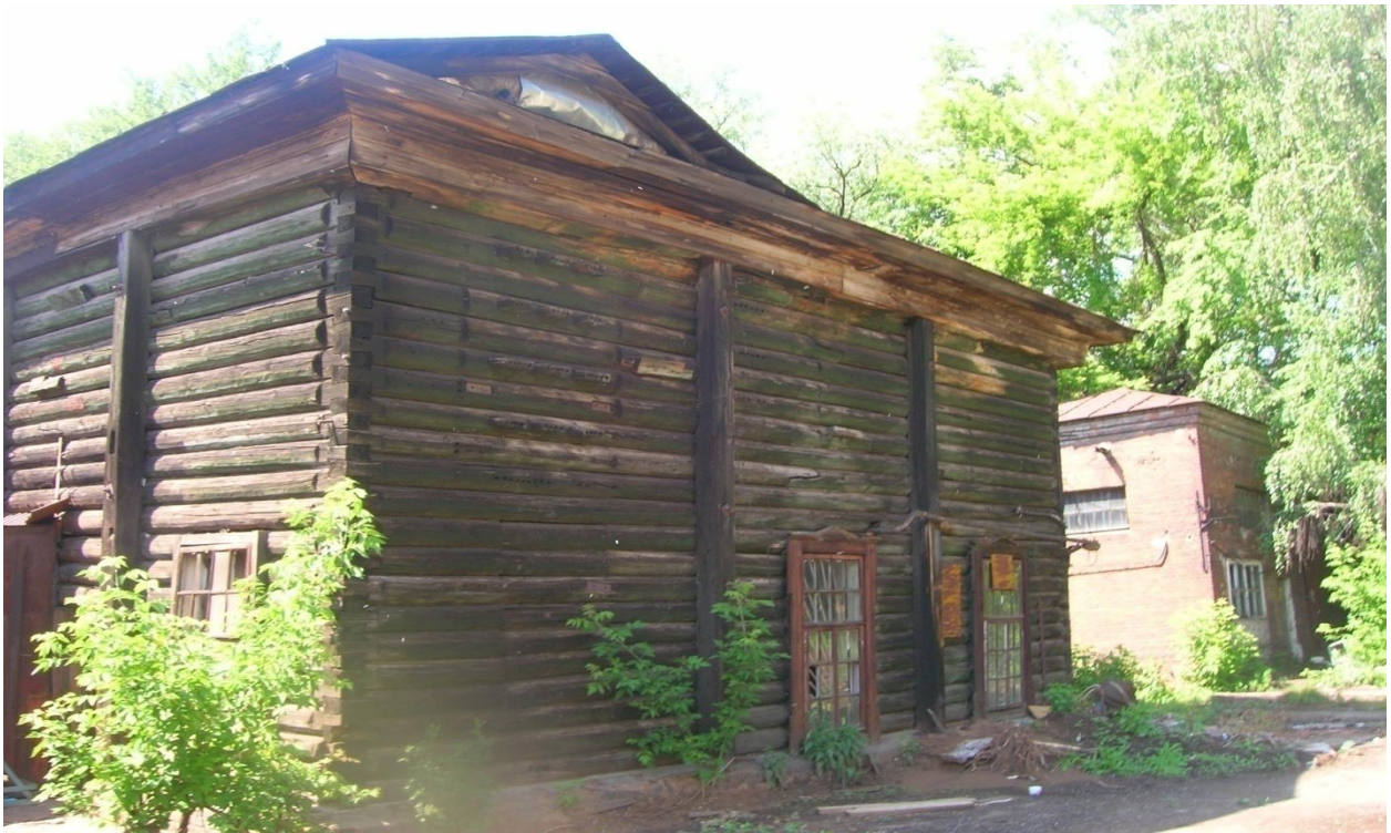
Рис. 4.22. Фото 2007 г. Юго-восточный угол деревянного здания Малой Водяной Турбины [В:8].
