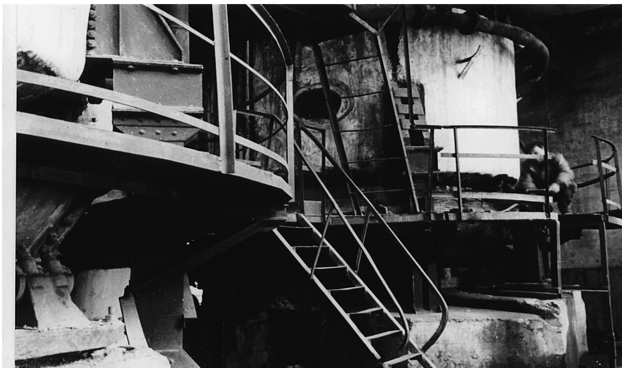
Рис.4.36. Фото 1950 г. Газогенератор ЦГТС
