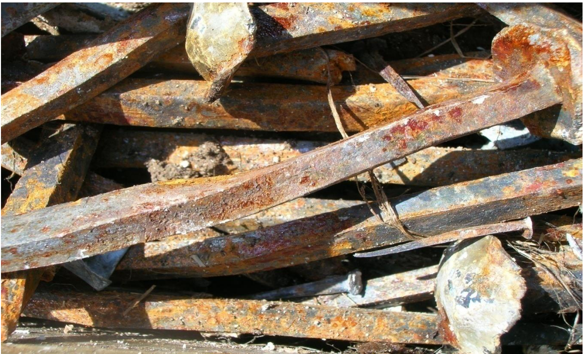
Рис. 4.25. Фото июль 2007 г. Этими кованными штырями длиной 250 мм были закреплены доски пола в Малой Водяной Турбины [В:8].
