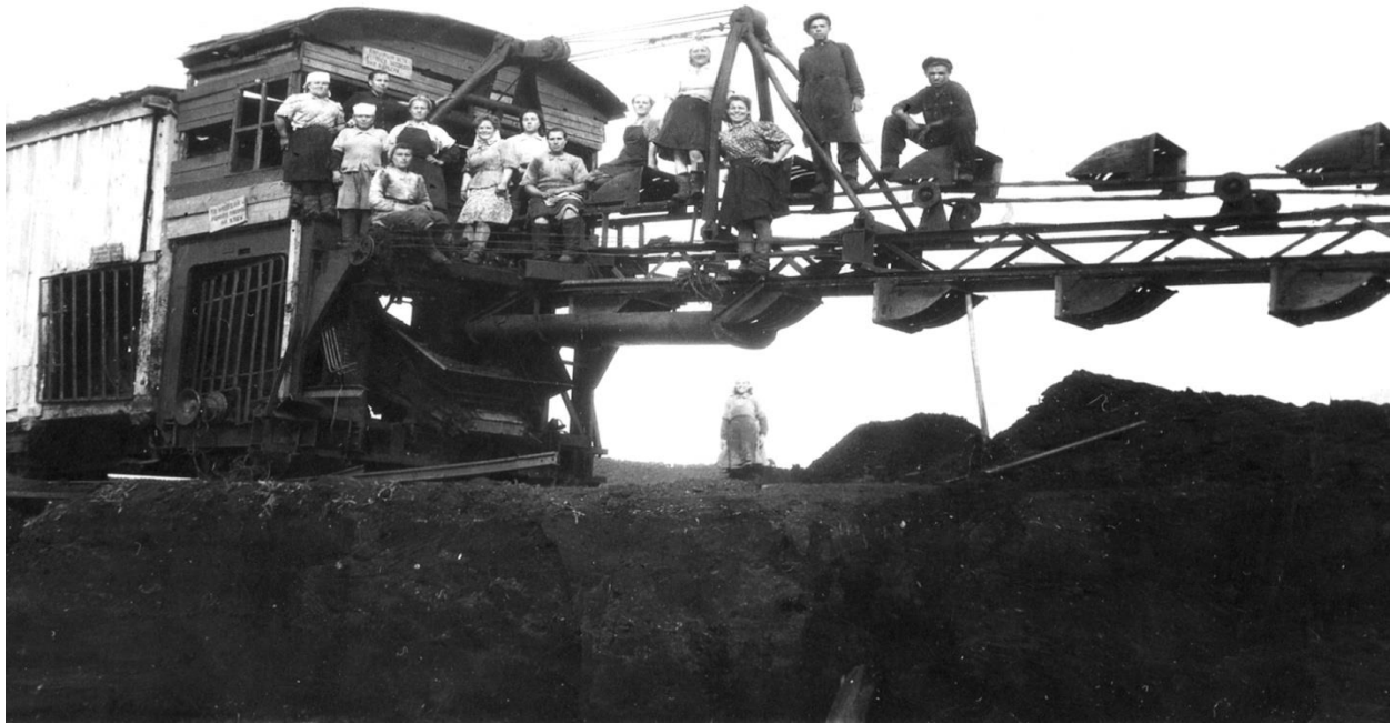
Рис. 4.32. Фото 1954 г. Торфопредприятие «Дзякино» Глазовского района Крайняя слева, кочегар местной котельной Т.Г. Барышникова
