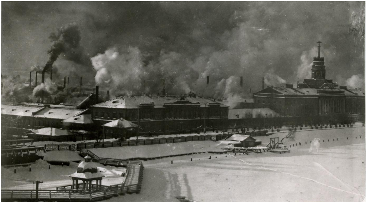
Рис. 4.16. Фото 1912 г. Слева ледорезная ограда плотины – вешняшный двор, на которой расположена Иордань, правее виден водозабор для Малой Водяной Турбины (МВТ) и через плотину, рядом с торцом здания главного корпуса – крыша здания самой МВТ.
