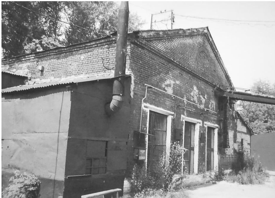
Рис. 3.7. Фото 2005 года. Котельная «Гудок» построенная в 1895 году
