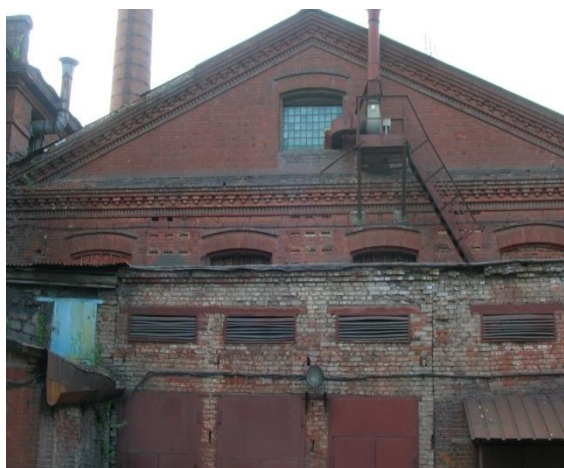
Рис.4.2. Фото 2005 г. Здание ЦЭС Ижевского завода
