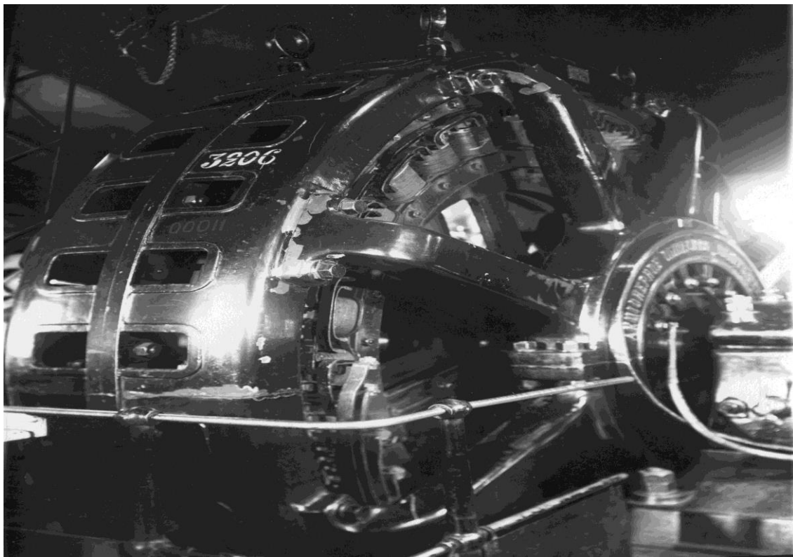
Рис. 4.15. Фото 1971 г. Генератор Большой Водяной Турбины «ФРЕНСИСА»
