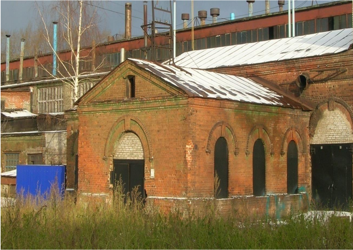
Рис. 4.10. Фото 2006 г. Существующее здание Большой Водяной Турбины. Западный фасад [В:8].
