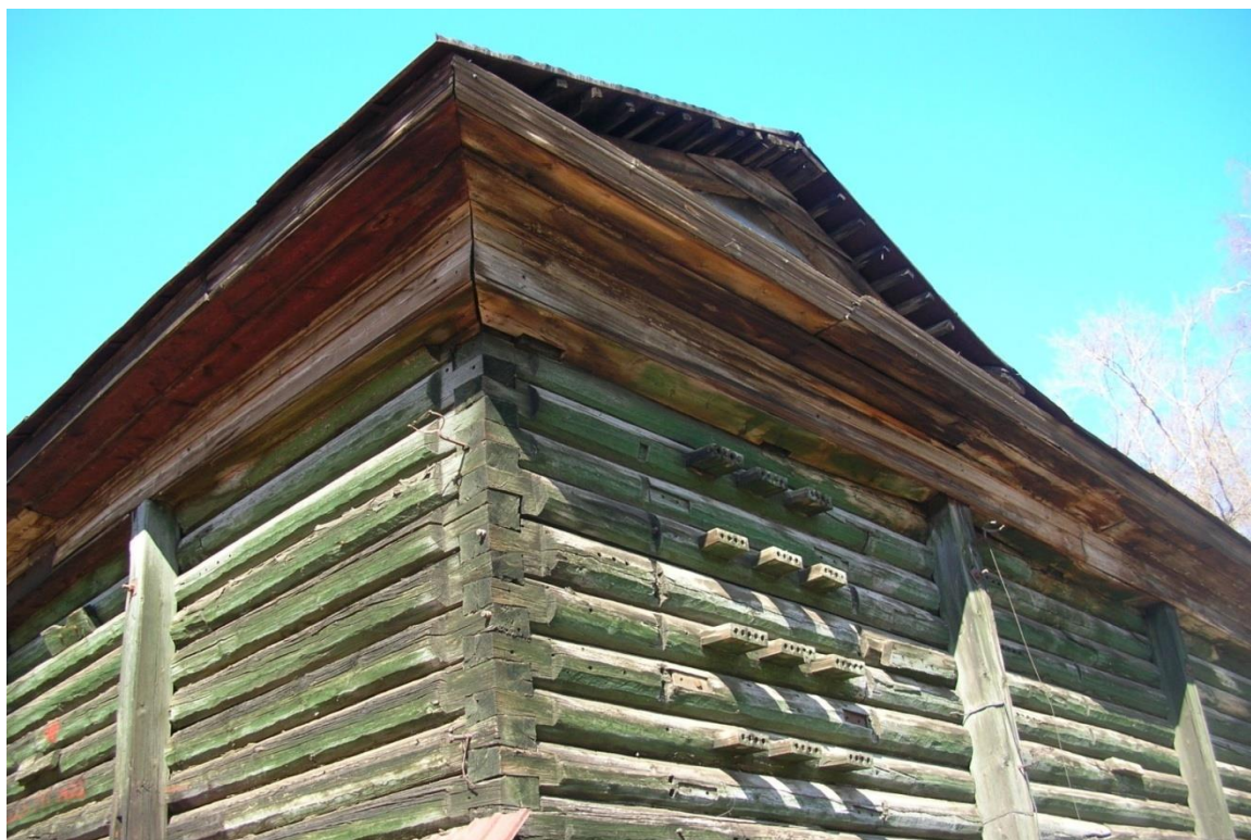
Рис. 4.21. Фото 2007 г. Юго-восточный угол деревянного здания Малой Водяной Турбины [В:8].
