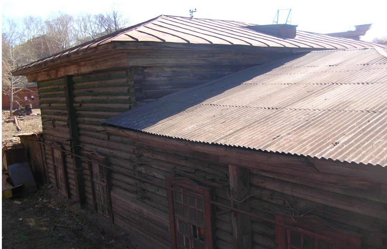
Рис. 4.19. Фото 2006 г. Здание Малой Водяной Турбины. Северный фасад [В:8].
