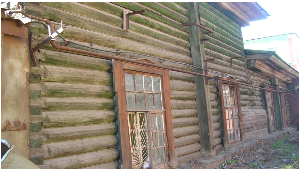
Рис.4.20. Фото 2007 г. Здание Малой Водяной Турбины. Северный фасад [В:8].
