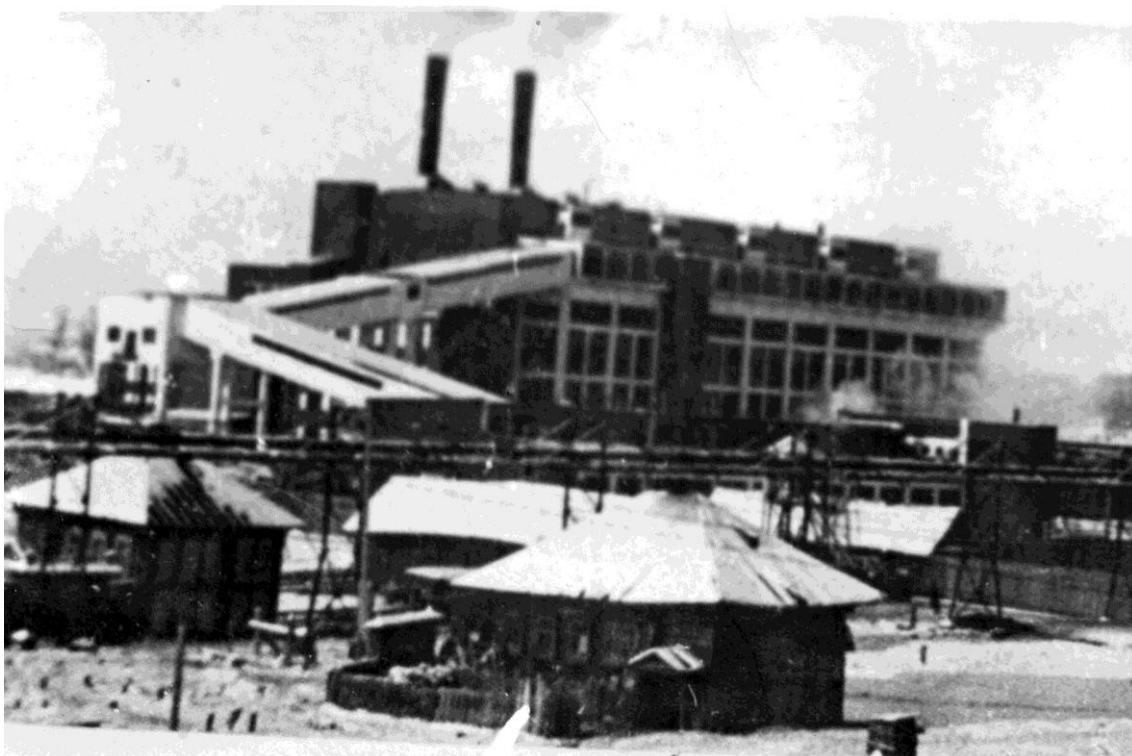
Рис. 4.31. Фото 1934 г. ТЭЦ Ижевского завода после пуска в эксплуатацию
