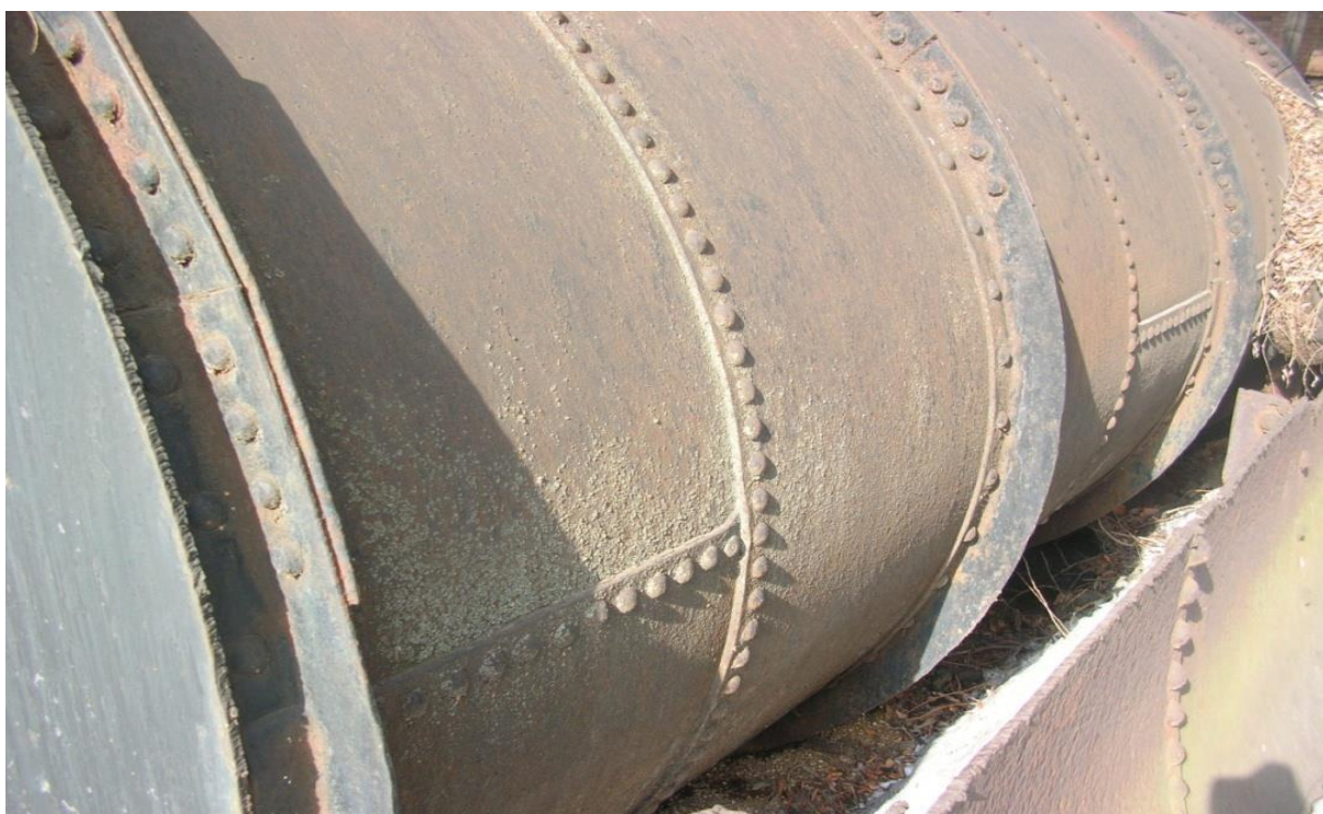
Рис.4.9. Фото 2010 г. Сохранившийся участок клёпанного водовода к Большой Водяной Турбине [В:8].
