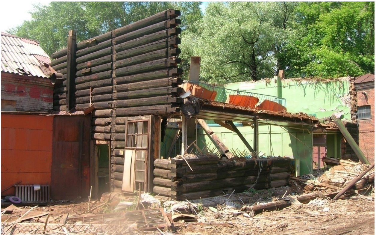
Рис. 4.23. Фото июль 2007 г. Разборка здания Малой Водяной Турбины [В:8].
