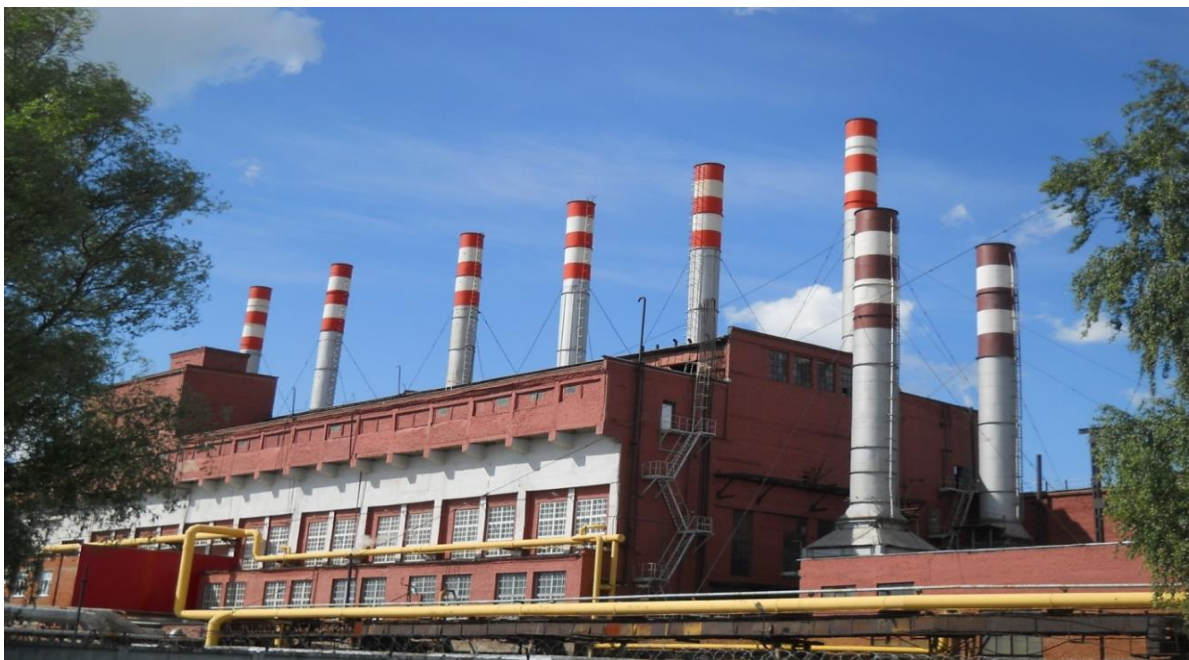
Рис. 4.33. Фото 2010 года. Производственный блок Ижевской ТЭЦ-1
