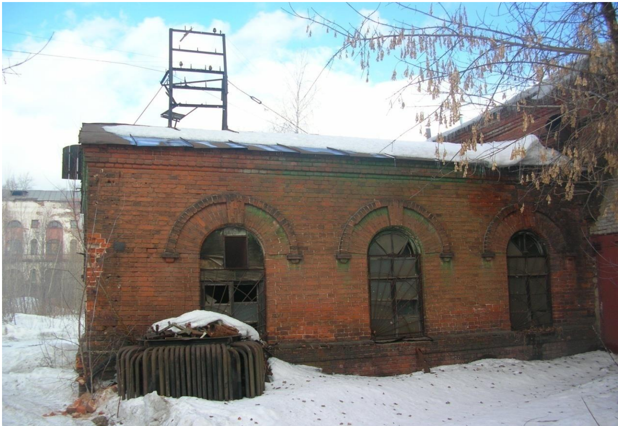
Рис. 4.12. Фото 2007 г. Здание Большой Водяной Турбины. Южный фасад [В:8].
