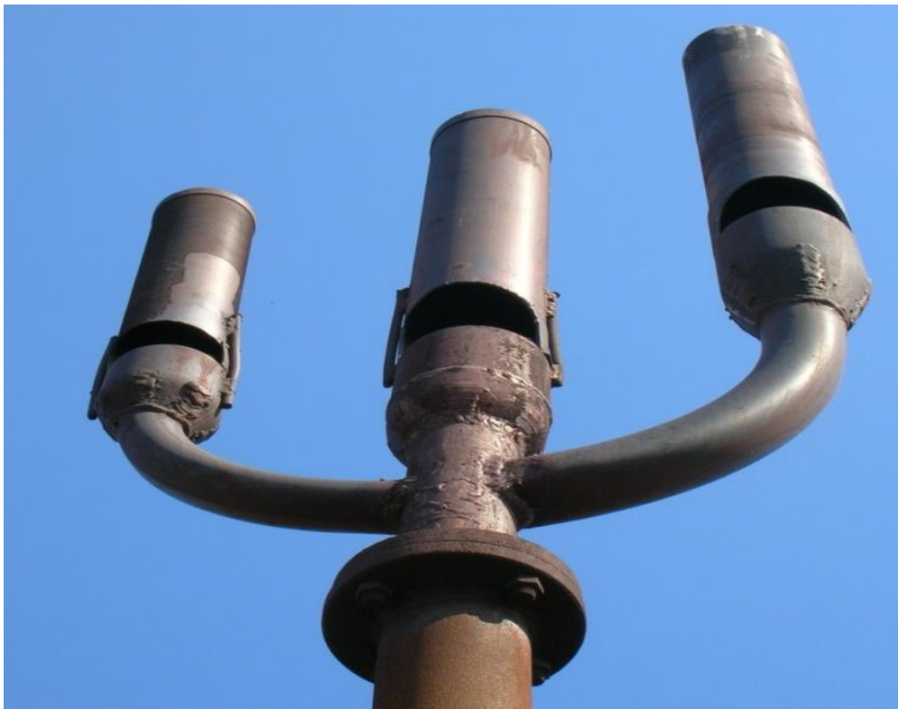
Рис. 3.8. Фото 2005 г. Современный трёхголосый гудок из нержавеющей стали, установленный на здании бывшей ЦЭС
