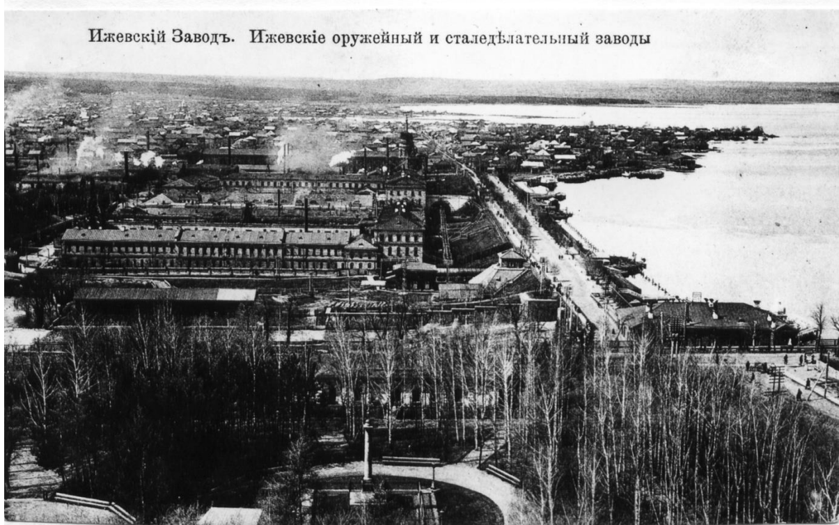
Рис. 4.16. Фото 1912 г. Слева ледорезная ограда плотины – вешняшный двор, на которой расположена Иордань, правее виден водозабор для Малой Водяной Турбины (МВТ) и через плотину, рядом с торцом здания главного корпуса – крыша здания самой МВТ.
