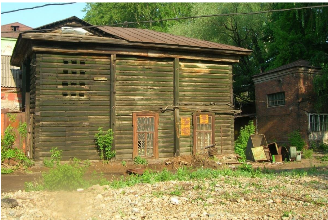
Рис. 4.18. Фото 2007 г. Деревянное здание Малой Водяной Турбины. Восточный фасад [В:8].
