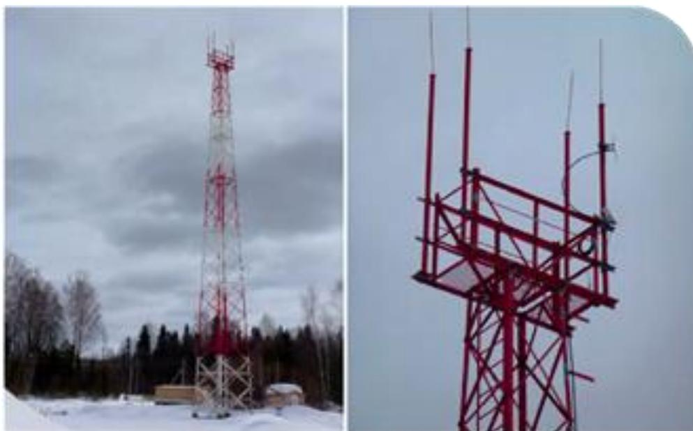
Рис. 2. Опора связи широкополосного радиодоступа (технология WiMAX) на Мишкинском нефтяном месторождении ПАО «Удмуртнефть» им. В.И.Кудинова
