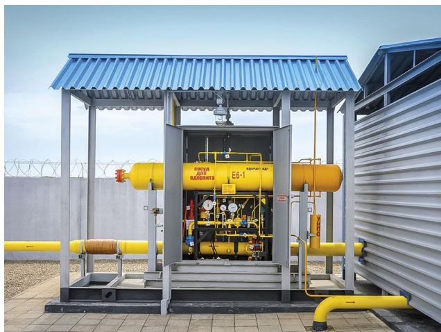
Рис.3. автоматическая система одоризации газа
