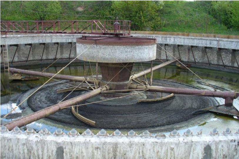
Рис. 27 Вторичный отстойник
