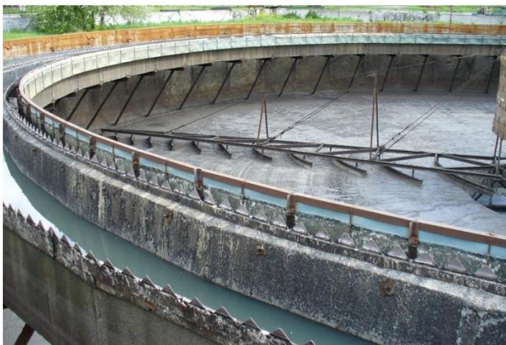
Рис. 20б Скребокый механизм для сбора осадка
