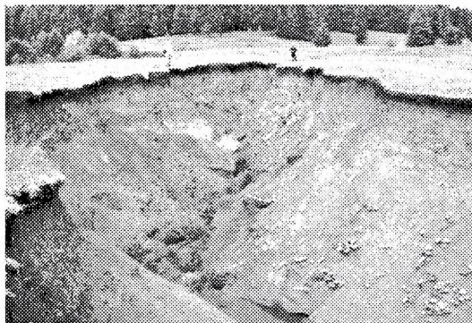
Рис. 5. Овраг на пойме р. Варзинка, возникший в результате прорыва двух земляных дамб прудов, расположенных в балке (2008 г.)
