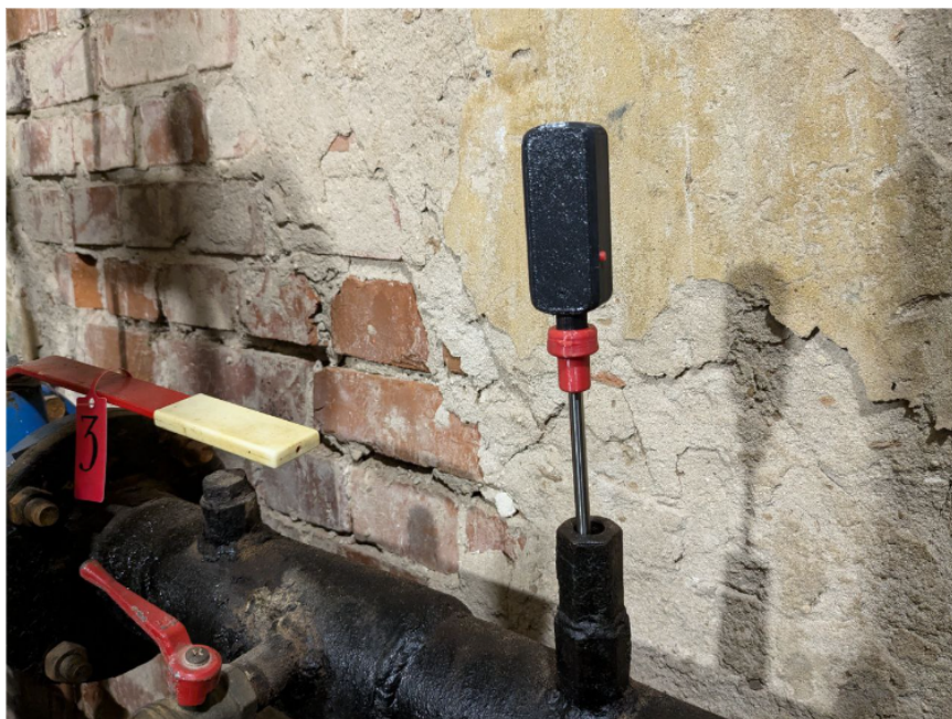
Рисунок 7 — Датчик температуры Efekta T1 v2 в корпусе с щупом, помещенном в термостакан
