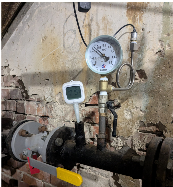
Рисунок 1 — Термометр SONOFF SNZB-02LD в термостакане и датчик давления EFEKTA PST V1 (подключен параллельно с манометром, через сифонную трубку) на подающем трубопроводе системы отопления
