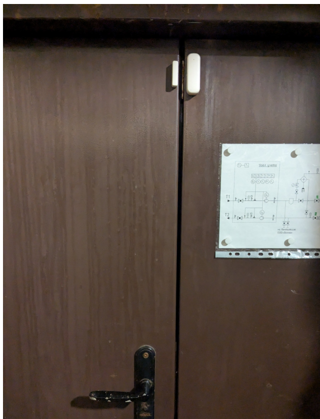
Рисунок 3 — Датчик открытия двери, установленный в помещении ИТП.
