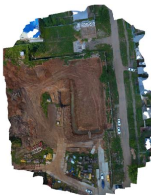
Рис. 4. Ортофотоплан местности после разработки котлована
